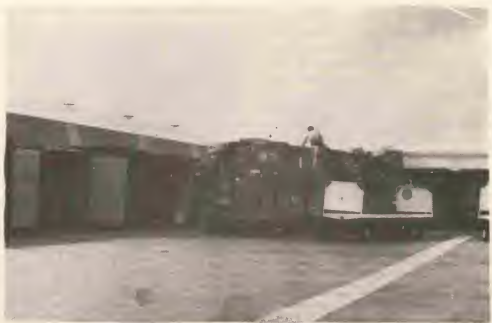
E edificio na aeropuerto pa ricibi carga ya no ta adecuado mas y den su lugar lo bini un edificio nobo di 3,8 millon florin. Esaki ta un otro proyecto di Gobierno Insular pa modernisa e aeropuerto Internacional di Aruba.
